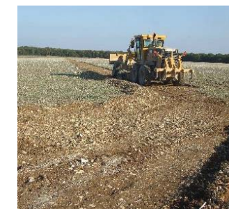
Décapage pour câblage
