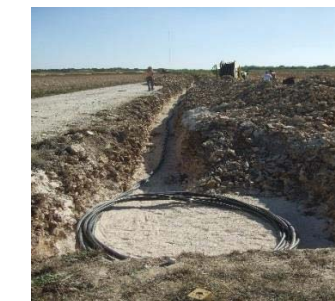
Pose de réseaux HTA
