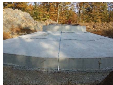
Massif d'éolienne avec ceinture équipotentielle pour MALT
